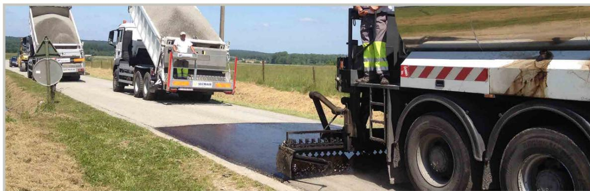
Des entretiens effectués à temps augmentent la durée de vie d'une voirie. À titre d'exemple, si un enduisage est bien fait et réalisé à temps, il pourra être appliqué deux fois de suite avant qu'un raclage-pose ne s'impose. De même, si le raclage-pose est bien fait et réalisé à temps, il pourra être suivi de deux nouvelles couches d'enduit. De cette manière, on prolonge le moment où une réfection complète est nécessaire.
